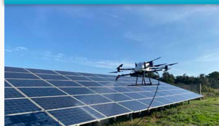
NETTOYAGE DE PANNEAUX SOLAIRES
