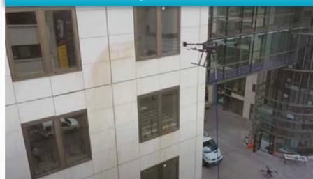
NETTOYAGE DE FAÇADES
