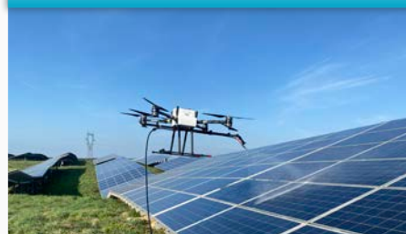
NETTOYAGE DE PANNEAUX SOLAIRES
