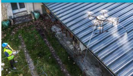
NETTOYAGE DE TOITURES
